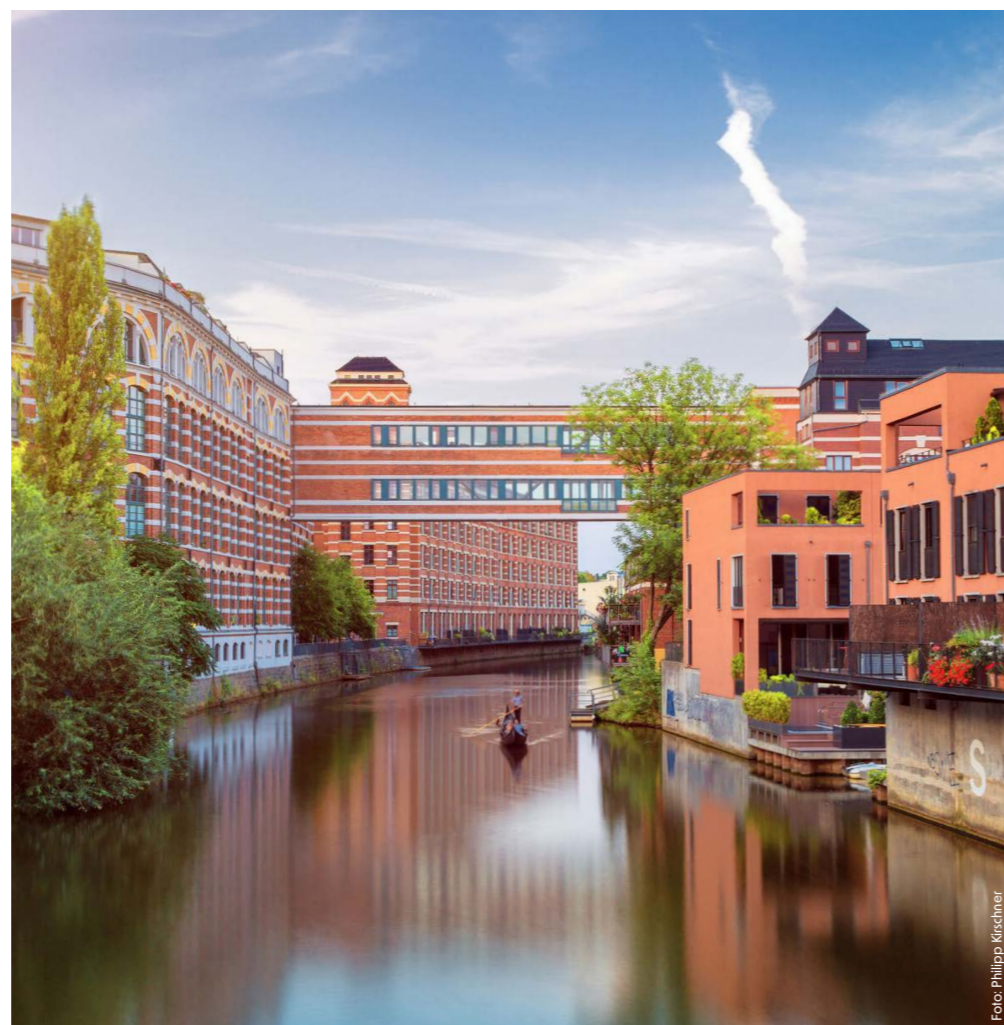
Beeindruckendes Industriedenkmal im Szeneviertel Plagwitz – die ehemaligen Buntgarwerke am Karl-Heine-Kanal
